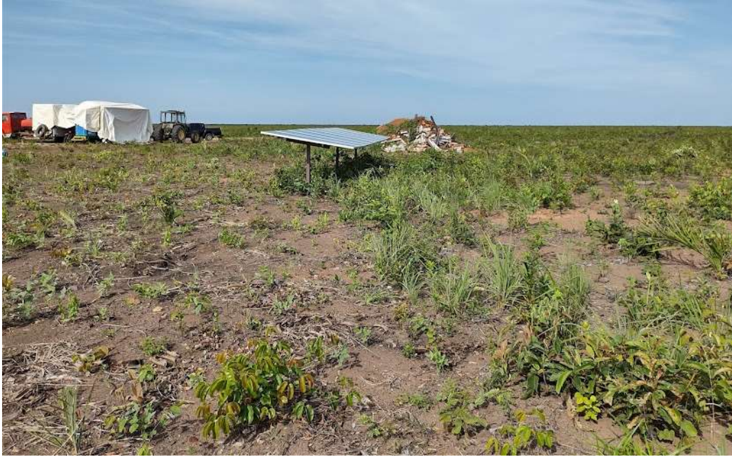
Protótipo de geração de energia solar de apoio a infraestrutura do empreendimento
