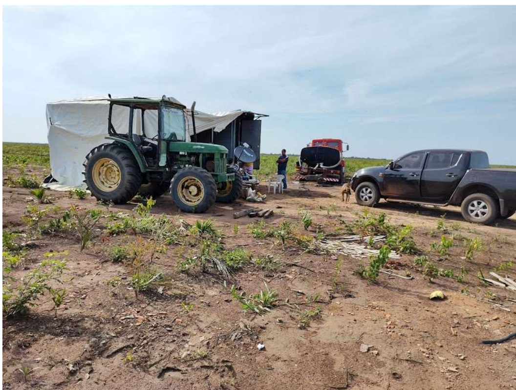
Área de apoio para instalação de infraestrutura do empreendimento
