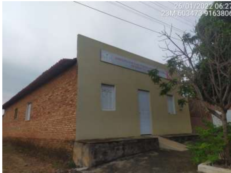
Foto 31 – Sindicato dos Trabalhadores Rurais de Sebastião Leal/PI. Fonte: CSA.
