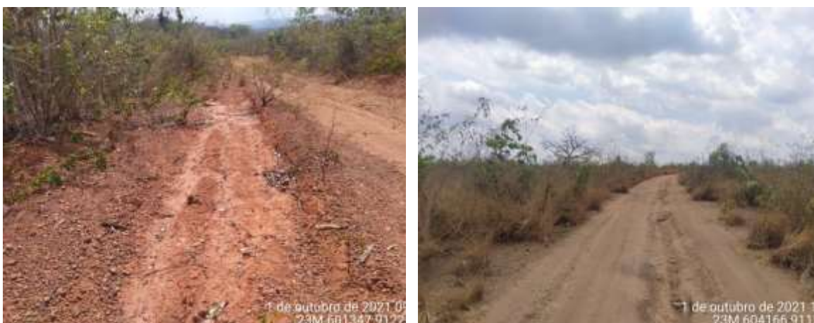
Foto 6 – (A) Ravina formada em área adjacente a corte de estrada estimulada pela retirada de cobertura vegetal na porção N nos limites da ADA; (B) Ravina presente em eixo de estrada carroçável desenvolvida pelo aumento do escoamento superficial em solo compactado na porção SE nos limites da ADA.
