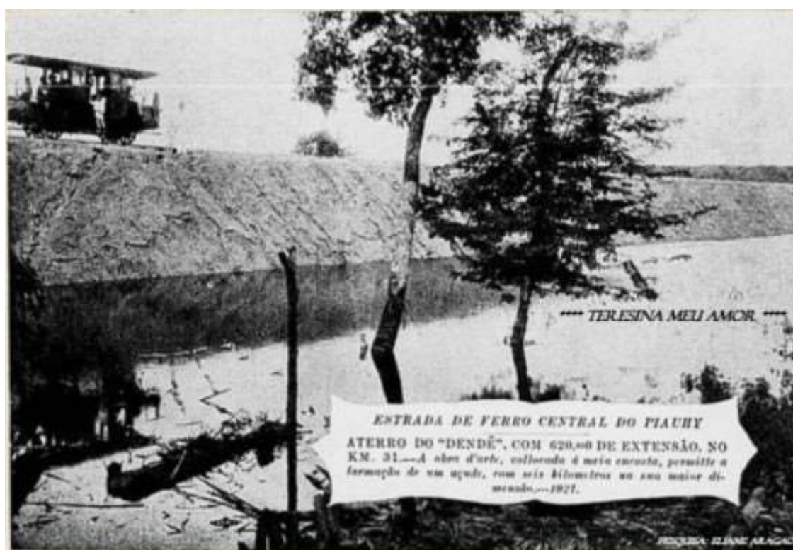
Foto 31 - Trecho férreo em construção
