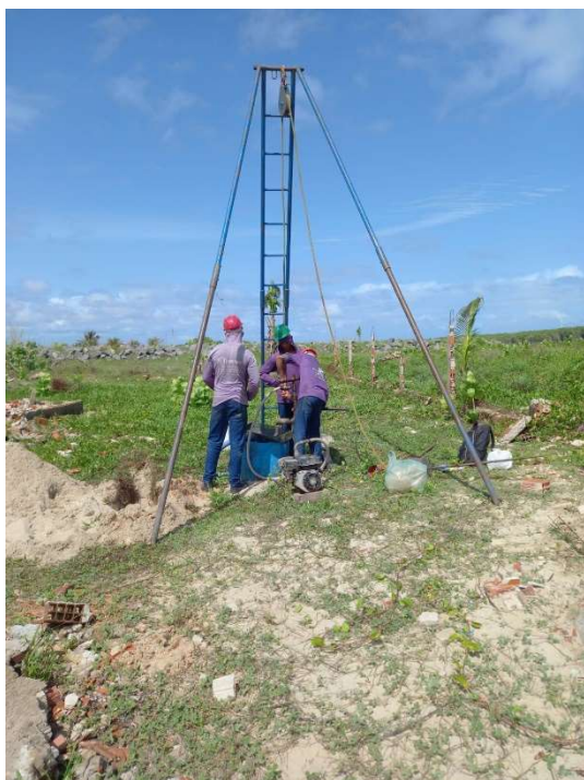
Foto 8 - Fotos da sondagem realizada no local do empreendimento
