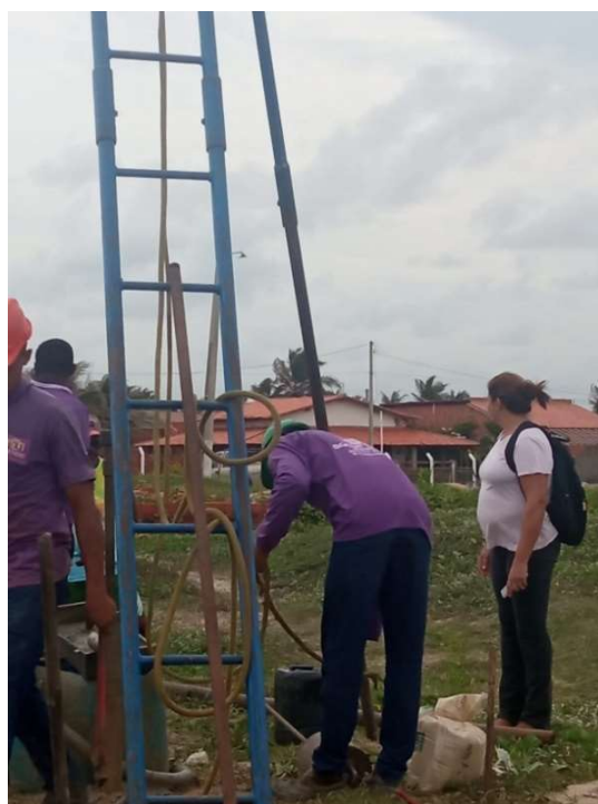
Foto 7 - Sondagem realizada no local do empreendimento.
