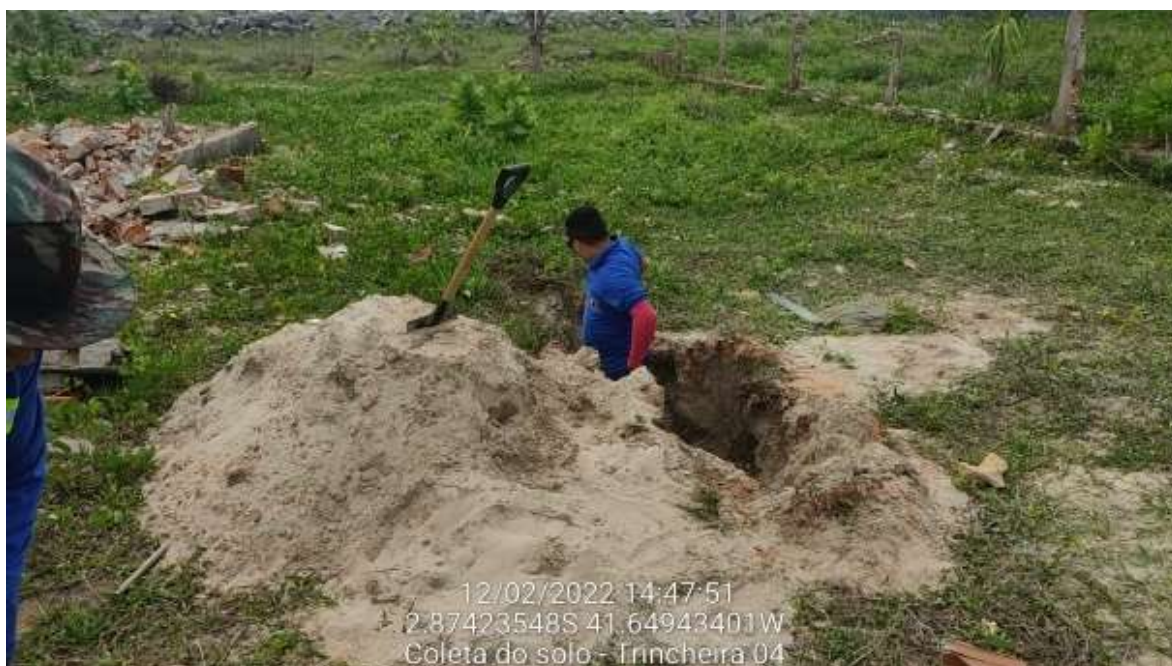
Foto 5 - Coleta do solo na Trincheira 04 no local do Empreendimento
