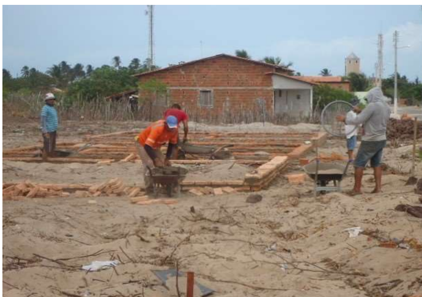
Construção dos imóveis do programa Minha Casa, Minha Vida em Cajueiro da Praia (2013).
