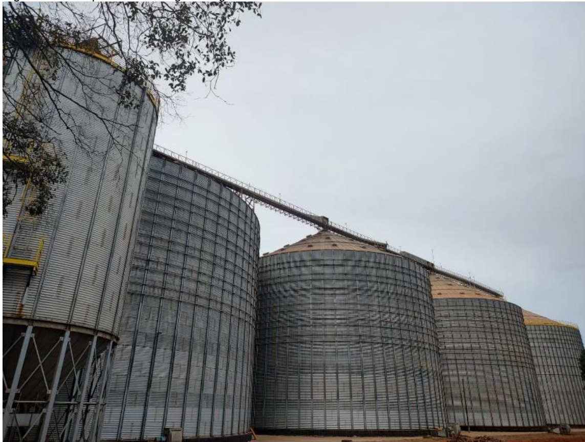
Figura 11: Silos para armazenagem de grãos.
