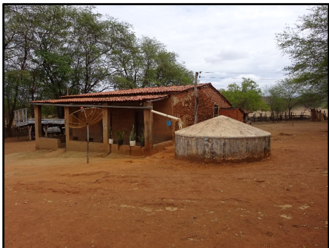
FOTO 6.4.9.1 – Cisterna instalada em residência rural, no Povoado Baixão do Moisés, em Caracol.
