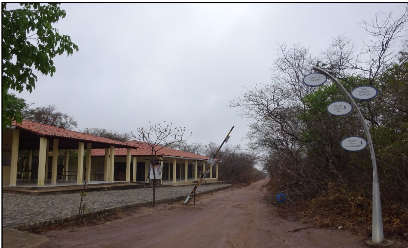
FOTO 6.4.4.5 – Centro de Visitantes do Parque Nacional da Serra das Confusões, localizado próximo à sede.
